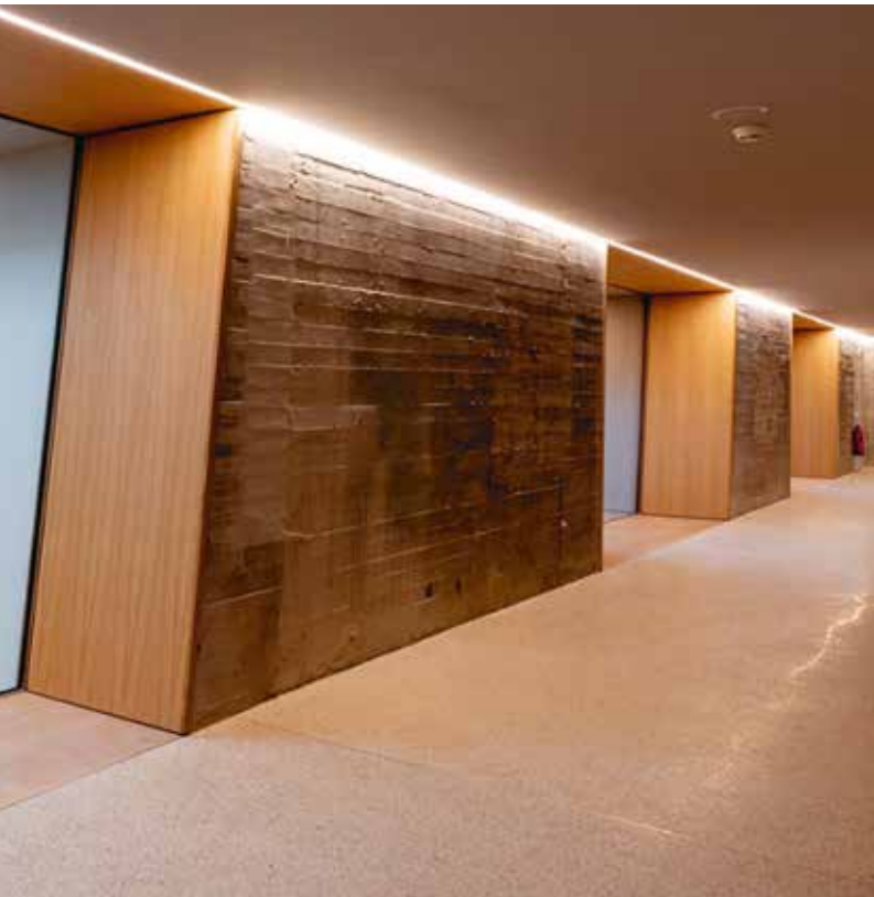
LET13 Lehmputz mit Reinsilikatlasur. Die Oberfläche hat eine gestreute Textur, ist leicht reliefiert. Enduit à l'argile avec lasure au silicate de potassium pur. La surface a une texture diffuse avec un léger relief.
