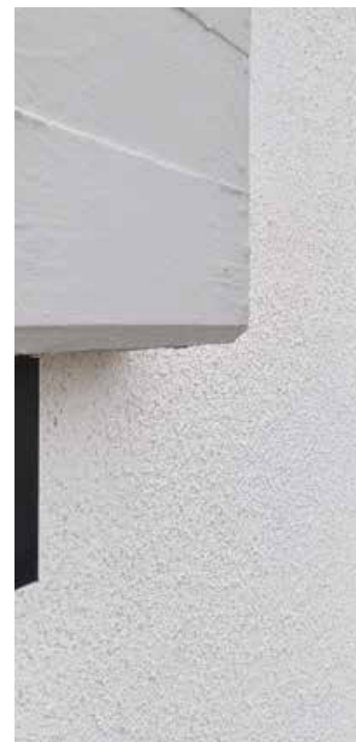
ANW11 Kellenwurf mit ausgeprägter Kraterbildung. Die Oberfläche hat eine gestreute Textur und ist sehr stark reliefiert. Enduit jeté à la truelle avec formation de cratères prononcée. La surface a une texture diffuse avec un très fort relief.
