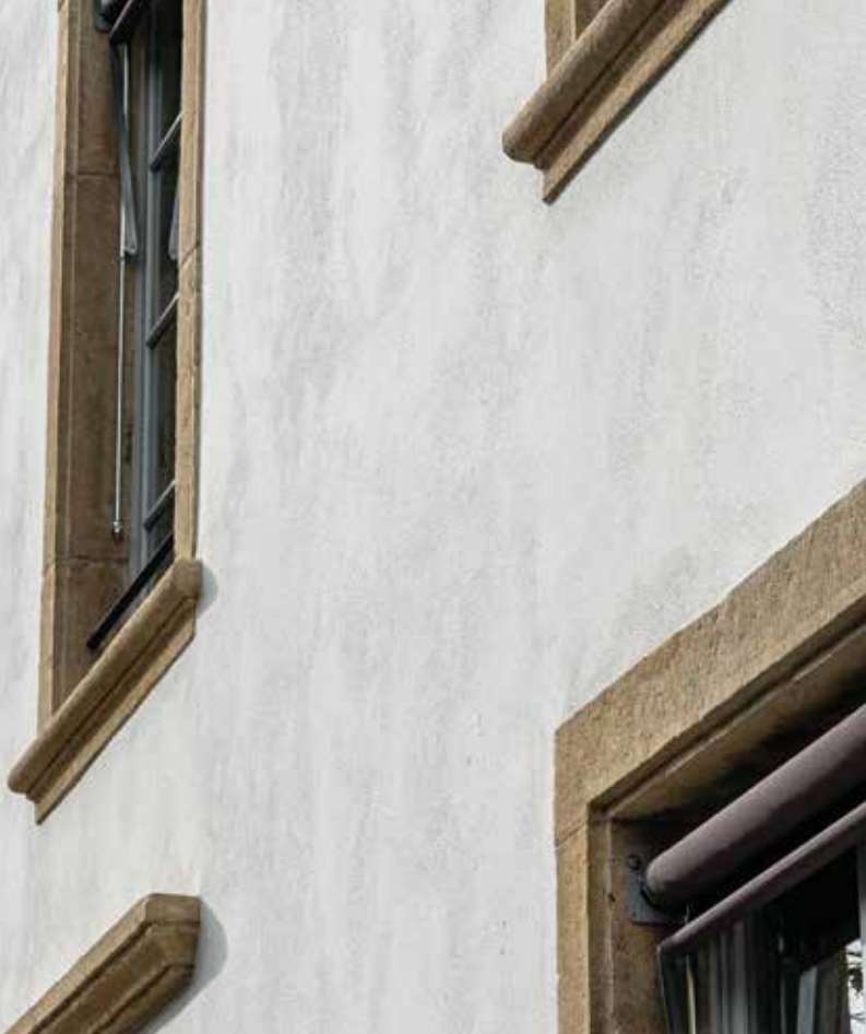
LET11 Ockriger Lehmputz Abrieb mit Lehm-schlämme. Die Oberfläche hat eine gestreute Textur und ist leicht reliefiert. Crépi à l'argile ocre avec badigeon d'argile. La surface a une texture diffuse avec un léger relief.
