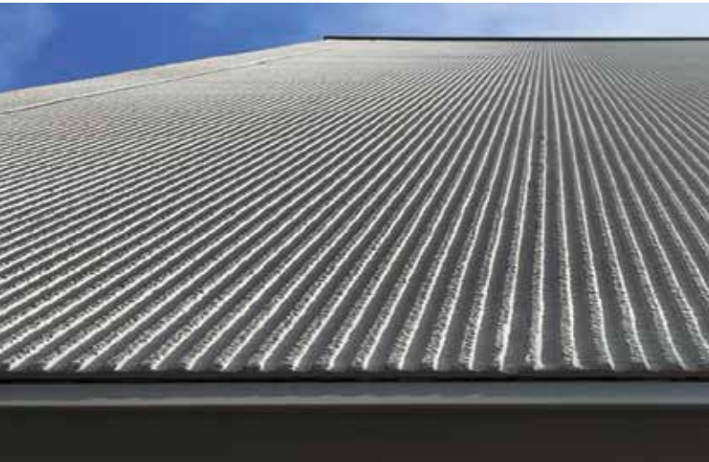
BUS05 Horizontaler Besenstrich mit dichter Körnung. Gebürstete, lineare Struktur mit leichtem Relief. Aspect brossé horizontal avec grain dense. Structure brossée, linéaire avec un léger relief.
