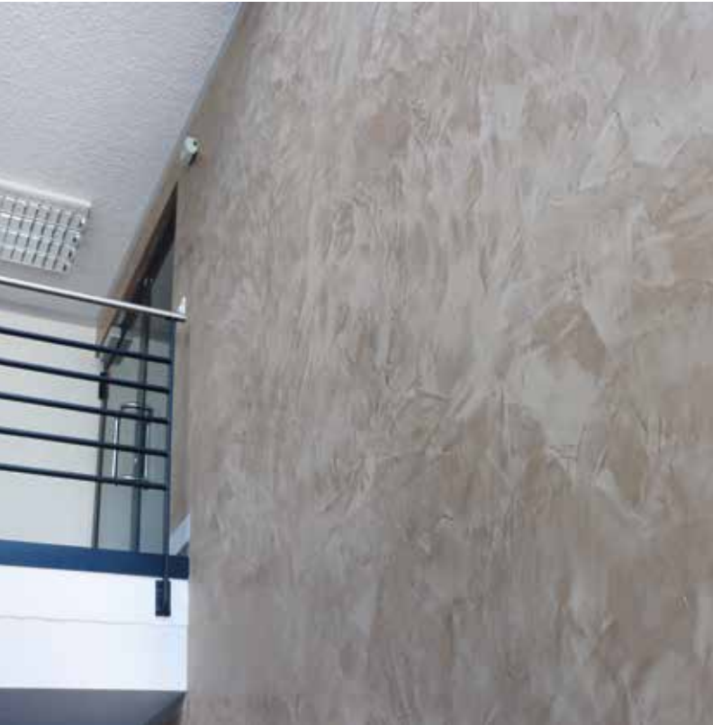
KAT10 Stuccolustro auf Schwarzputz . Die Oberfläche hat keine Textur und ist glatt. Stuccolustro noir . La surface n'a pas de texture et est lisse.
