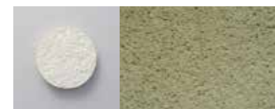
ANT05 Kratzputz mit Renovationsanstrich. Die Oberfläche hat eine gestreute Textur und ist mittel reliefiert. Crépi gratté avec peinture de rénovation. La surface a une texture diffuse avec un relief moyen.
