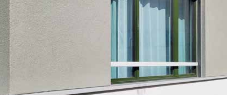
MEP04 Ölversilberung. Die Oberfläche hat keine Textur. Sie hat einen mittleren Glanz. Peinture à l'huile argentée. La surface n'a pas de texture. Elle a une brillance moyenne.
