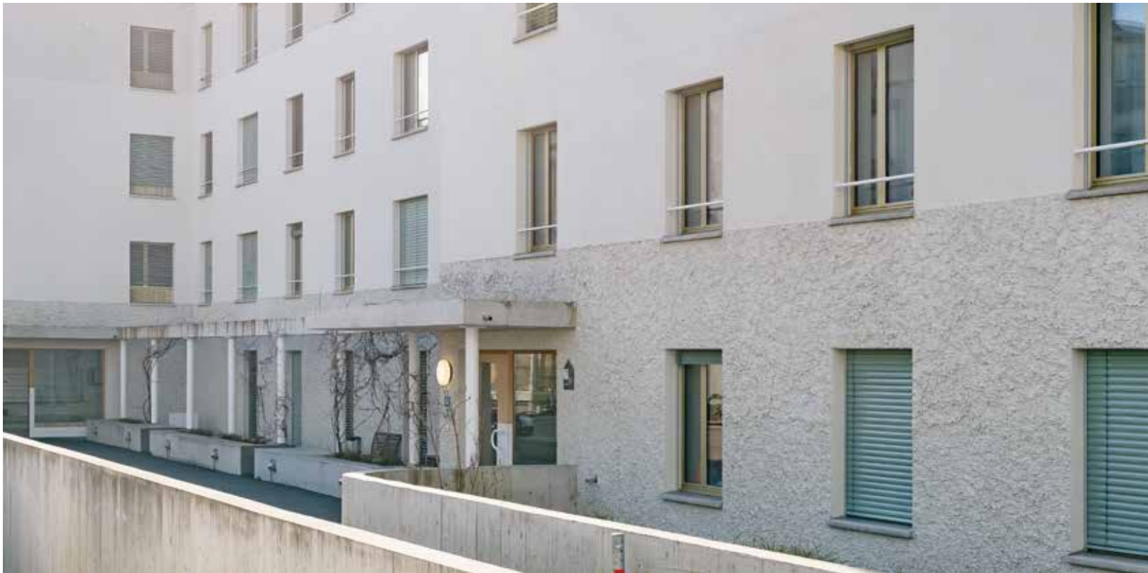
Übergang Kellenwurf zu Feinputz.
