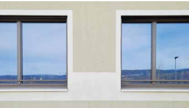
BUS08 Horizontaler Besenstrich mit grober Struktur. Gebürstete, lineare Struktur mit starkem Relief. Aspect brossé horizontal avec structure grossière. Structure brossée, linéaire avec un fort relief.
